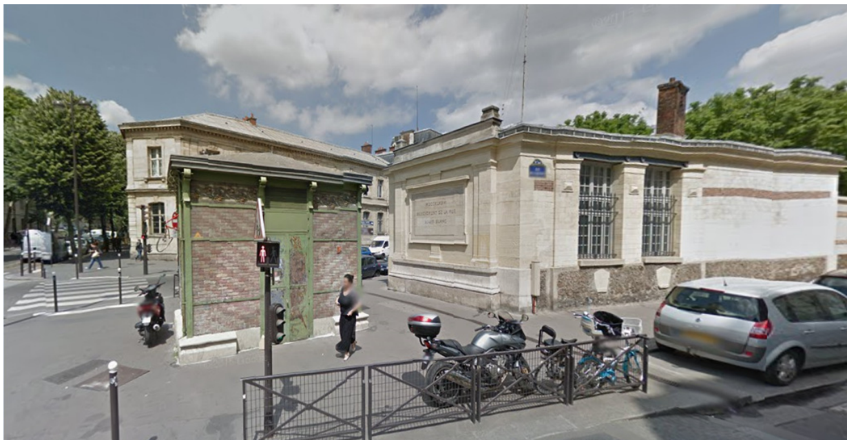
Rue de l'Aqueduc, Paris
